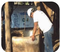
Perforación de Pozo Mecánico.
