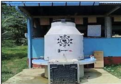
Obra SCALL de la comunidad de Kaibil Balam de la Microrregión 3
