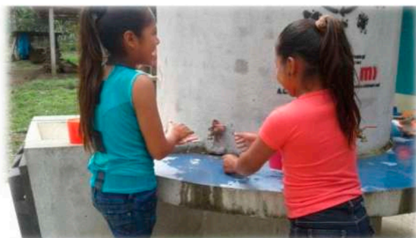
Estación de lavado de manos con jabón
