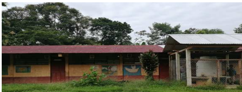
Sistema de Captación de Aguas de Lluvia en buenas condiciones y funcionamiento
