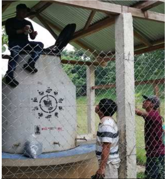
Cambio de Carbón activado en los 50 sistemas de Captación de Aguas de Lluvia
